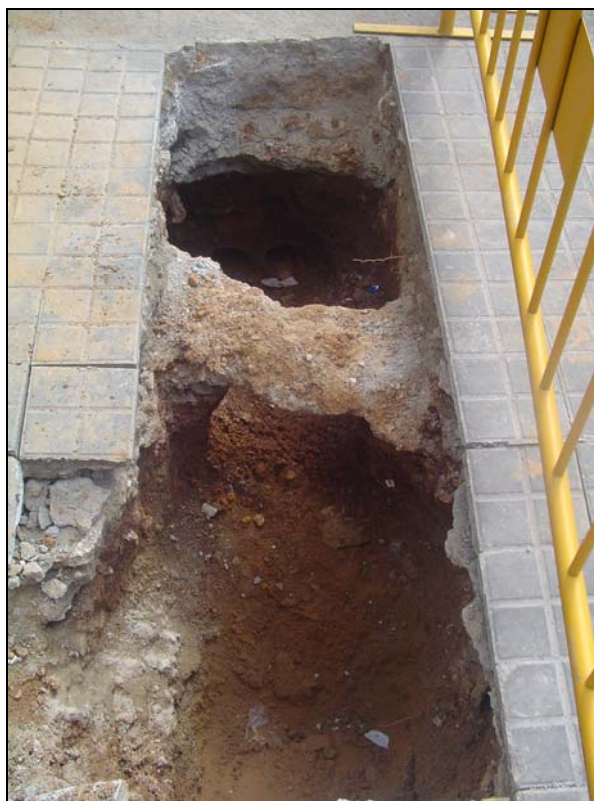
Il·lustració 3: Sondatge efectuat al carrer Loreto amb l'encreuament amb l'avinguda Sarrià.
